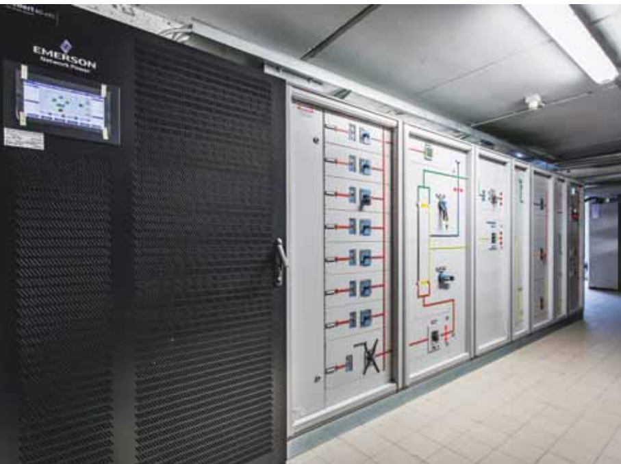
quadri elettrici in struttura ospedaliera
