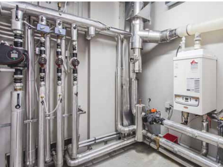
centrale termica in un'industria di medio/grandi dimensioni
